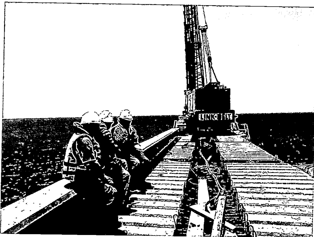
Visita del Ing. John Jamanca para verificar prueba de carga en el eje 166
