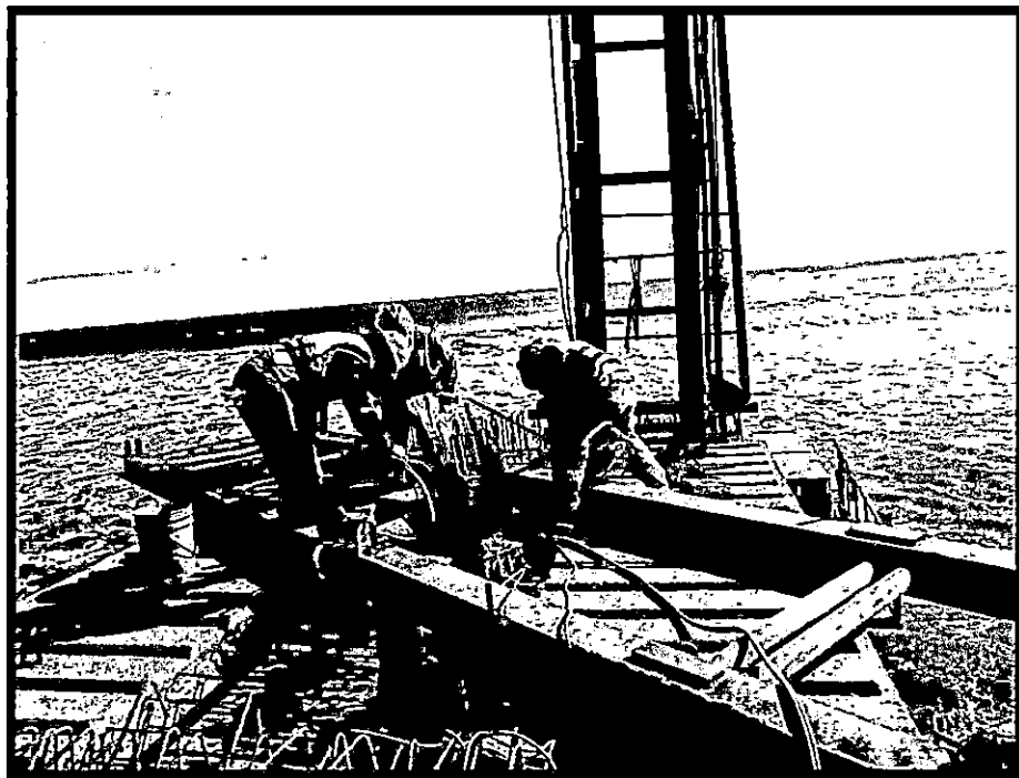
DESCABEZADO DE PILOTES
